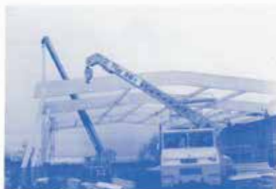
Construction en cours du Centre Sportif polyvalent
