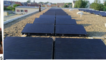
Installation panneaux photovoltaïque aux écoles
